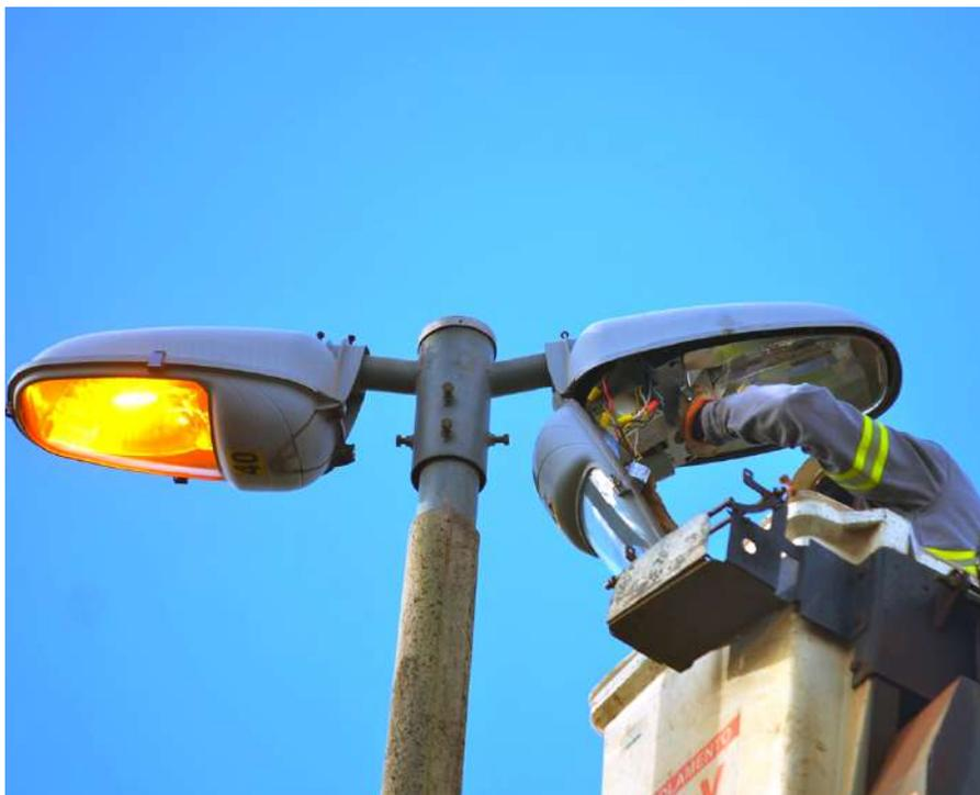
Nos últimos dias, o Guará recebeu um mutirão para manutenções em diversos postes que estavam apagados. Troca de lâmpadas, relés, reatores, disjuntores, fusíveis e reposição de cabos são exemplos de manutenções realizadas por empresas terceirizadas pela CEB.
