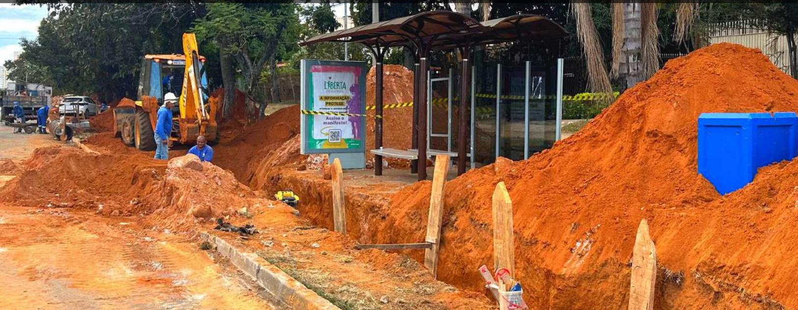
A pedido da Administração do Guará, a Caesb trabalha desde o início desta semana na substituição de coletores de esgoto na QE 30. A obra vai modernizar e garantir mais eficiência nas redes de água e esgoto da região. Partes da via e calçadas estão interditadas. Agradecemos a compreensão de todos. ⚠️
